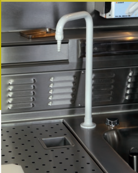
Distributeur de formol et évacuation des déchets de formol Fresh formalin dispenser, formalin waste drain
