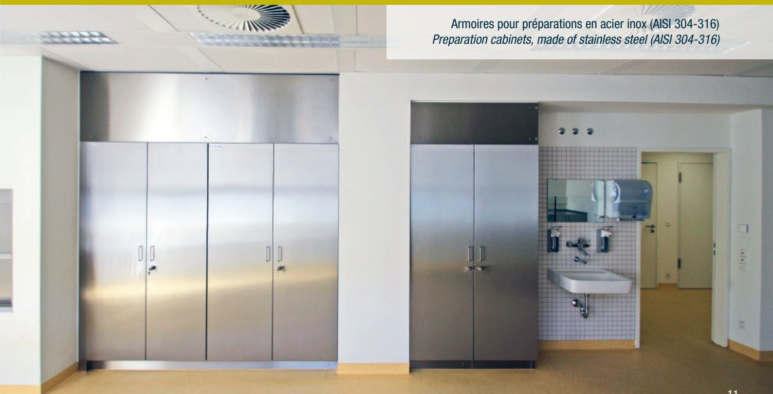
Intérieur d'armoire pour préparations, aspiration par le plafond, entrée d'air au sol (air local ambiant) Inside of Preparation cabinet, ceiling ventilation incoming air at the base (room air)
